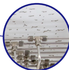
食込継手箇所拡大
