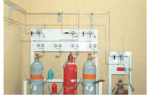
ボンベ収納室
